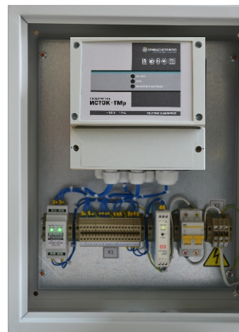
Рис 2.7 СИ ИСТОК-ПАР-07, пример внутренней компоновки монтажных шкафов на базе вычислителя ИСТОК-ТМз и расширителя ИСТОК-ТМр
